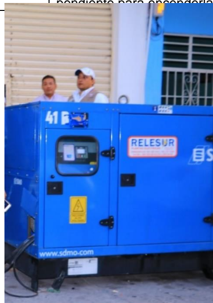
Planta de energía de emergencia instalada en el CCE.
